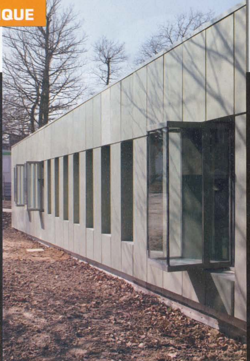
Ce lycée de Dammarie-les-Lys (Seine-et-Marne), ainsi que son extension, ont été carrossés à l'aide de panneaux préfabriqués en ciment composite verre (CCV). Une réponse technico-architecturale à la nécessité de donner une unité d'ensemble à des bâtiments disparates.
